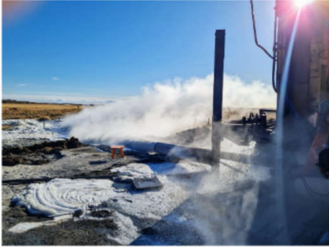
Mynd 5: Hóla í blæstri með lofti í rúmlega 120 m. Vatnsmagn um 50-70 l/s
